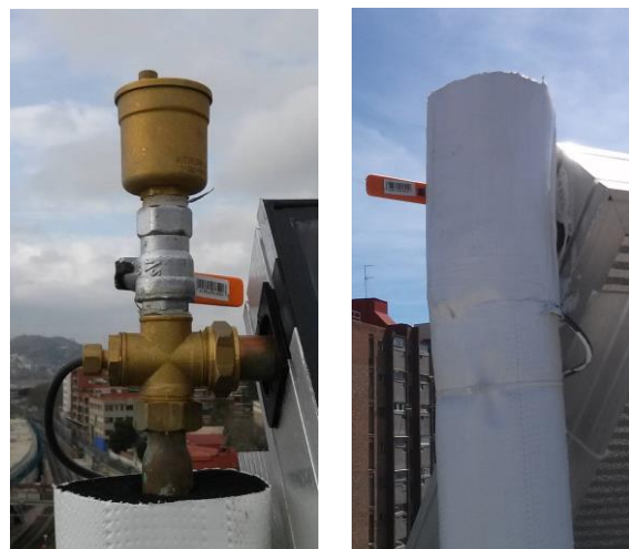
Figure 22. Position de la sonde de température dans les capteurs solaires (TSC). Source : Tecsol
