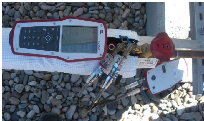
Figure 17. Vanne d'équilibrage Source : Tecsol
